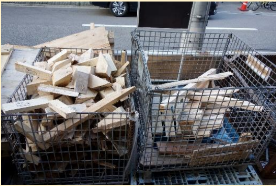
廃材は引き取ってもらえるサイズに解体して保管
